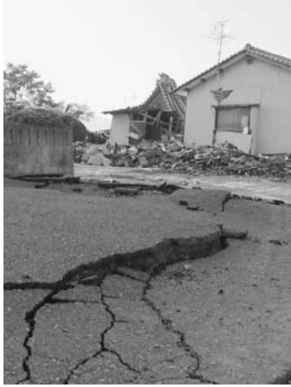
地面に亀裂と段差、家屋も倒壊
