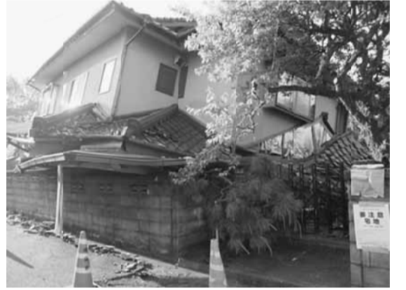
益城町には倒壊した家屋が多数
